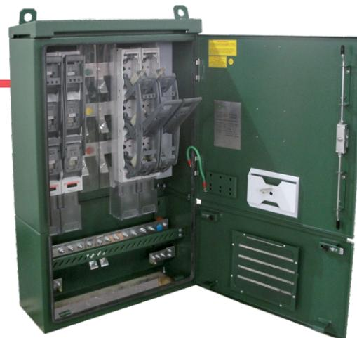
centros verticais das barras, as seccionadoras possuem larguras de 50mm para bases NH-00 e 100mm para bases NH-1, 2 e 3;
